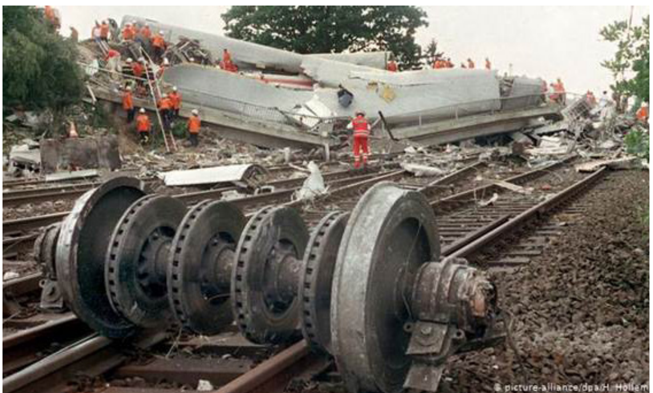
ภาพที่ 4 : แสดงอุบัติเหตุรถไฟตกรางในประเทศเยอรมันเมื่อปี ค.ศ.1998 ทำให้มีผู้เสียชีวิตถึง 101 คน และมีผู้บาดเจ็บจำนวนมาก ถือเป็นเหตุการณ์ ที่เลวร้ายที่สุด ซึ่งมีสาเหตุมาจากการเสื่อมสภาพของปลอกล้อรถไฟจาก แรงที่กระทำซ้ำ ๆ
