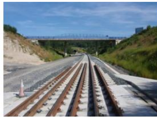
รูปที่ 7 ตัวอย่างตำแหน่งเปลี่ยนผ่านระหว่างทางรถไฟแบบมีหินโรยทางและพื้นคอนกรีต
