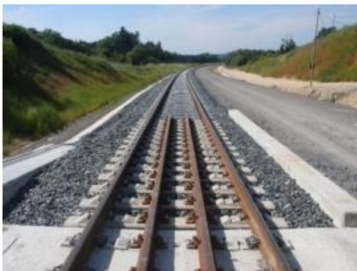
รูปที่ 7 ตัวอย่างตำแหน่งเปลี่ยนผ่านระหว่างทางรถไฟแบบมีหินโรยทางและพื้นคอนกรีต
