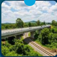
จุดตัดต่างระดับ
