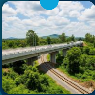
จุดตัดต่างระดับ
